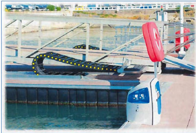
Figure 7 : Exemple de système de chenille pour réseaux (AR Marima - Port du Havre)
